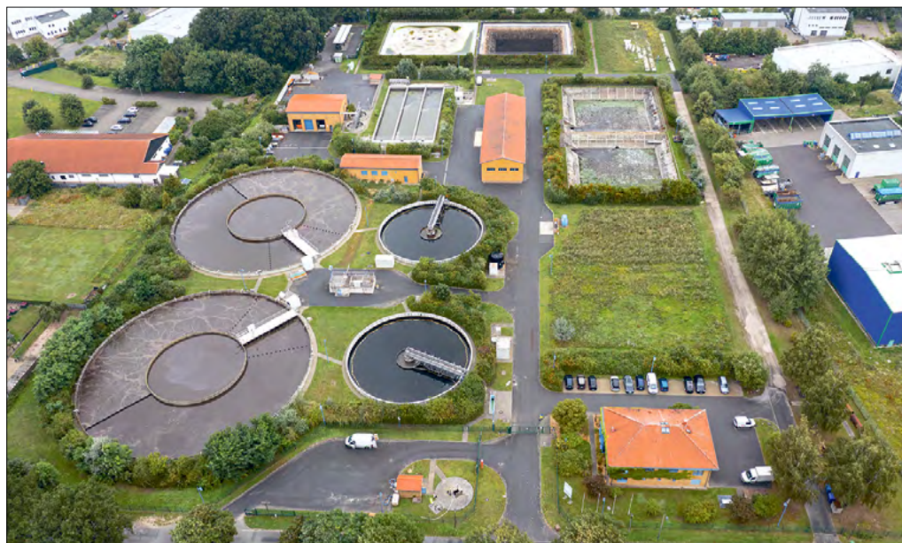
Nach 20 Jahren immer noch ein technisches Meisterwerk – die WARL-Kläranlage.
