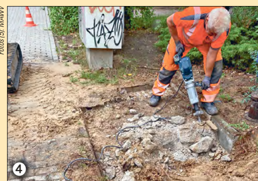
Über der Bruchstelle muss viel Beton entfernt werden. Das ist nicht die einzige Herausforderung.
