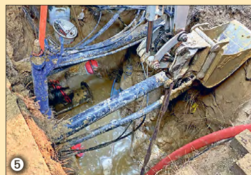
Die Baggerschaufel „tanzt Slalom“ durch die vielen Leitungen anderer Medien über dem Wasserrohr.
