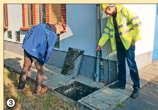
MAWW-Technikchef Falko Börnecke (l.) und -Bauleiter Nick Amlang prüfen Leitungs-Abspermmöglichkeiten.
