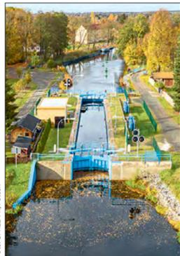
Der fast 100 Jahre ungenutzte Kanalabschnitt des Langen Trödels zwischen Liebenwalde (im Bild) und Zerpenschleuse wurde von 2013 bis 2015 einschließlich des Neubaus einer Schleusenanlage 2, zweier Klappbrücken und einer Hubbrücke wiederhergestellt.
