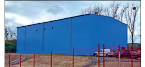
Das ist der Garant für die jederzeit stabile Wasserversorgung von Großbeeren. Fotos (2): WARL
