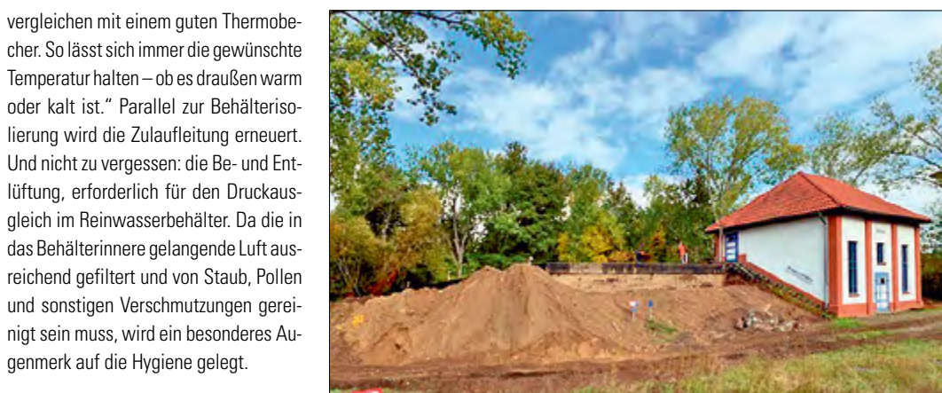
Das Werk Königs Wusterhausen (hier das Pumpenhaus) ging 1912 in Betrieb.
