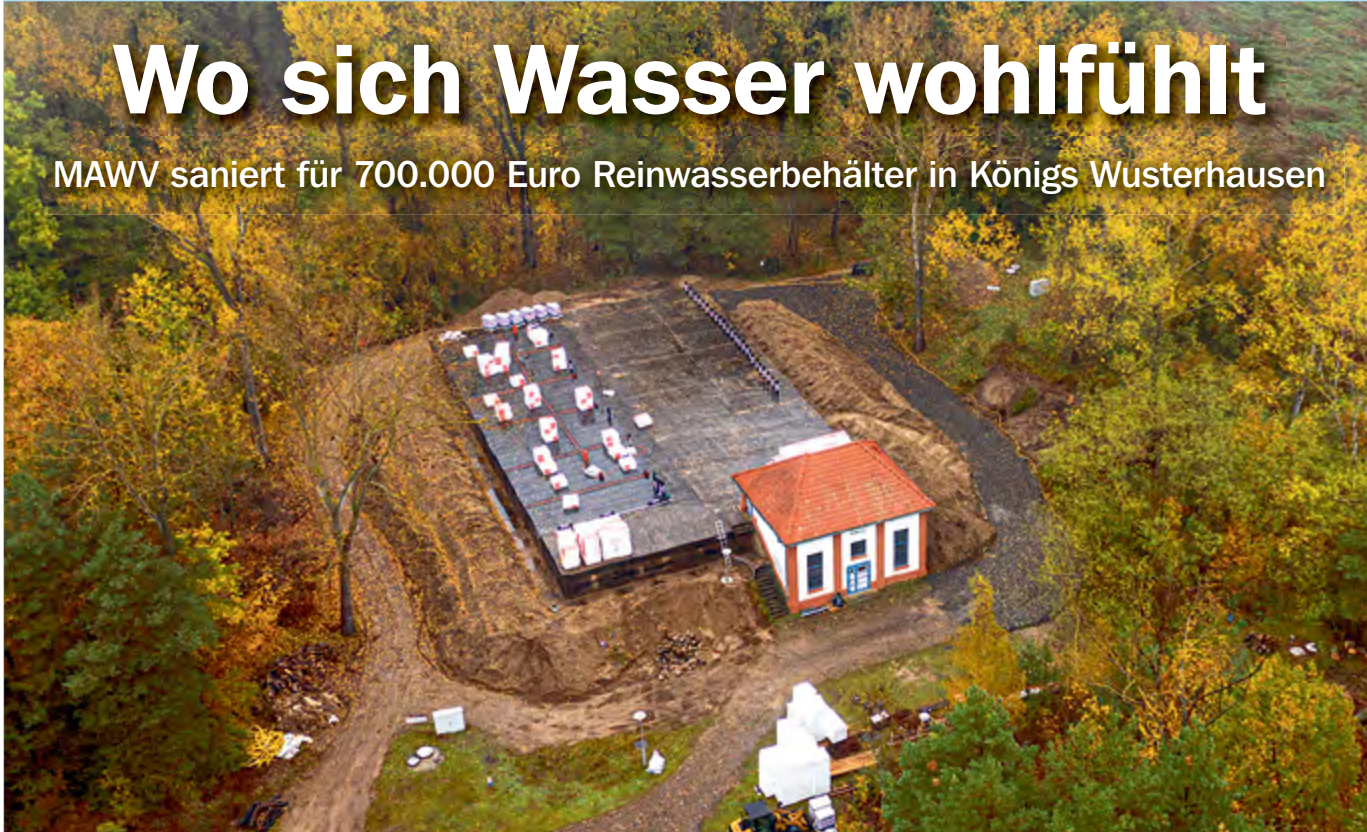
Die Reinwasserkammer misst 37,60 x 22 x 3 Meter und fasst damit sage und schreibe knapp 18.000 Badewannenfüllungen. Foto: SPREE-PR/Petsch
