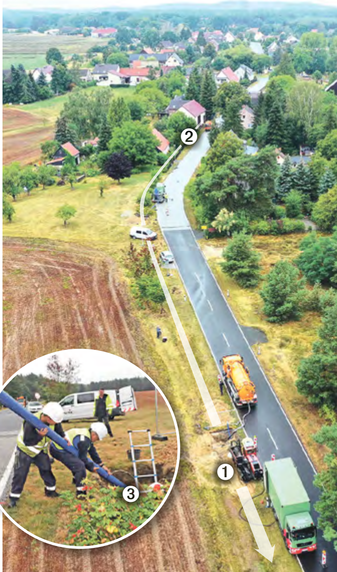
Der Horizontal-Spülbohrer ① zieht die Leitung von Limsdorf ② kommend unterirdisch ein. Kollegen der Firma SPIE beim „Einfädeln“ des 11 cm starken PE-Trinkwasserrohres in der Startgrube ③.
