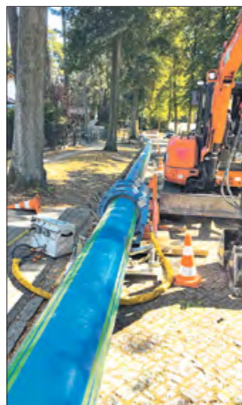
Die Ersatzleitung sichert die Trinkwasserversorgung in der Bauphase.
