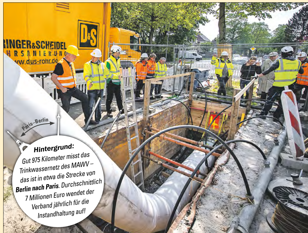
Eine Baumaßnahme der besonderen Art: Der Schlauchliner wird in die Startgrube eingezogen.
