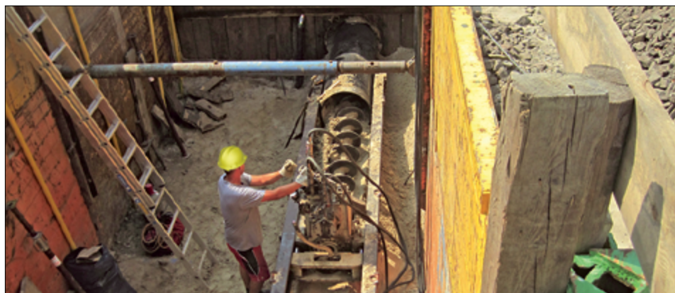
Hier wird das Schutzrohr unter den Bahngleisen hindurchgepresst. In diesem Schutzrohr wird dann die Leitung verlegt.
