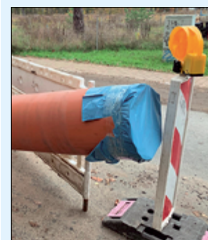
Die neue Abwasserdruckleitung hat einen Durchmesser von 40 Zentimetern. Foto: MAWW
