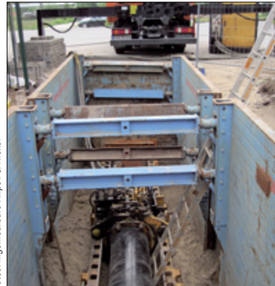
Hier wird das Schutzrohr unter den Bahngleisen hindurchgepresst. In diesem Schutzrohr wird dann die Leitung verlegt.
