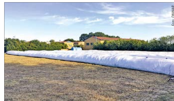
Der mit Cadmium belastete Klärschlamm der Kläranlage Ludwigsfelde wurde umgehend in Folienschläuchen verpackt. Zum Einsatz kamen Silageschläuche (35 m lang und 2 m im Durchmesser). Hier ist der Schlamm bis zu seiner umweltgerechten Entsorgung untergebracht.
