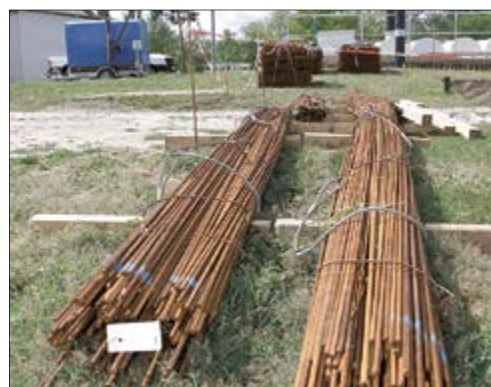
Für die nötige Stabilität: Die Eisenstreben verstärken bald die einzelnen Bauelemente des 2.500 m 3 fassenden Faulbehälters.
