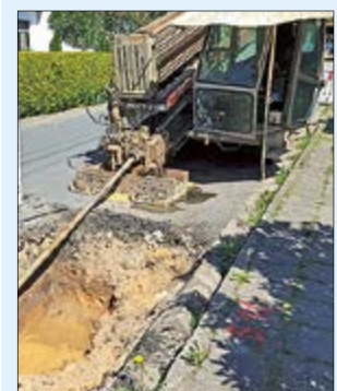
Beim Horizontalspülbohrverfahren muss die Staßen-decke nur punktuell geöffnet werden.
