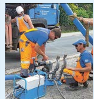
Seit Mai Tagesgeschäft: Kollegen der Baufirmen ver-schweißen die Rohrstränge.
