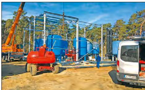
Mit der neuen Filterhalle für vier Trinkwasserfilter wurde der letzte Bauabschnitt der Sanierung des Wasserwerks Rangsdorfs beendet. Der alte Reinwasserbehälter ist in ein Zweikammersystem umgebaut und ein neuer Brunnen gebohrt worden.
