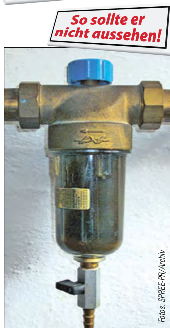
Diese Fotos zeigen rückspülbare Filter – wie sie aussehen sollten (oben) und wenn sie lange nicht gereinigt wurden (unten).
