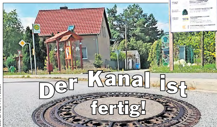
Löwendorf (hier die Wilhelmstraße) ist jetzt am Schmutzwasserkanal.
