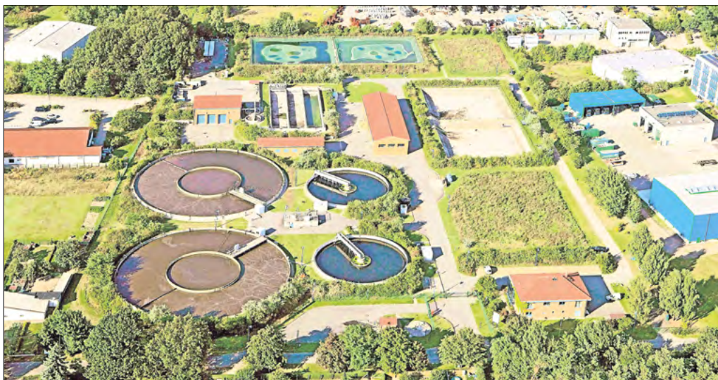
Kläranlagen wie diese in Ludwigsfelde gehören zu den „Energiefressern“ einer Kommune. Hier schlummert aber auch großes Potenzial für Energieeinsparungen.
