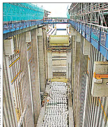
Im beweglichen Trog (unten) schwimmen die Schiffe, während sie gehoben oder gesenkt werden. Er ist gut doppelt so lang und in etwa so breit wie ein olympisches Schwimmbecken.
