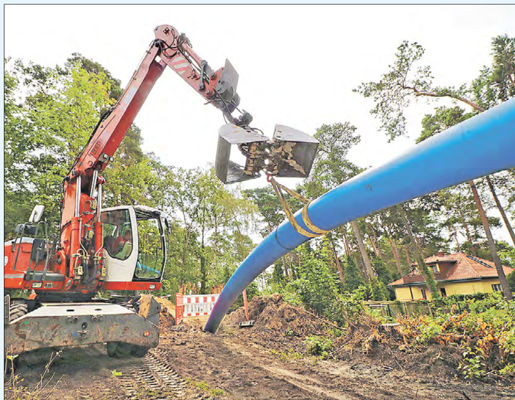
Die neue Wasserwerksausgangsleitung wird mithilfe eines Baggers Zentimeter um Zentimeter „eingezogen“.
