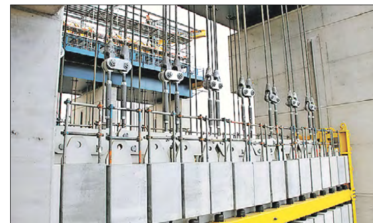
Der Trog ist an 224 Seilen aufgehängt. Diese sind mit 220 Gegengewichten verbunden, welche die Wanne im Gleichgewicht halten. Deshalb kann das neue Schiffshebewerk (wie schon sein Vorgänger) mit minimaler Antriebskraft arbeiten und muss lediglich Reibung, Anfahrwiderstände, Massenträgheit und geringe Wasserspiegeldifferenzen überwinden.
