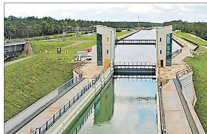
Die 65,50 m lange Kanalbrücke verbindet das Schiffshebewerk mit dem oberen Vorhafen. Sie bietet wie der Hebewerkstrog eine nutzbare Wasserspiegelbreite von 12,50 m. Das Sicherheitstor bildet das östliche Ende der Scheitelhaltung des Oder-Havel-Kanals. Rechts und links erhält die Brücke Seitenwege, die befahren werden können.
