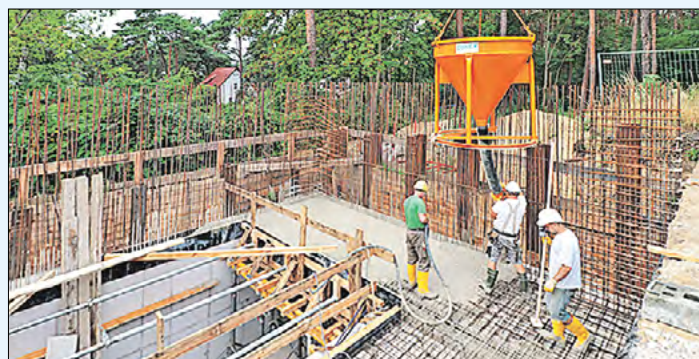
Die Zwischendecke des Bedienhauses wird mit Beton gegossen. Das Wasserwerk Rangsdorf versorgt etwa 13.500 Menschen in Rangsdorf und Dahlewitz mit dem Lebensmittel Nr. 1.
