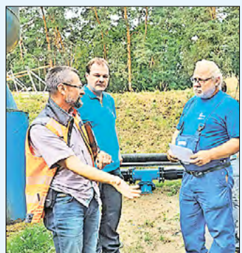
Wolfgang Kauert berät mit den Ingenieuren Klenke und Schulze (v. re.) die nächsten Arbeitsschritte.
