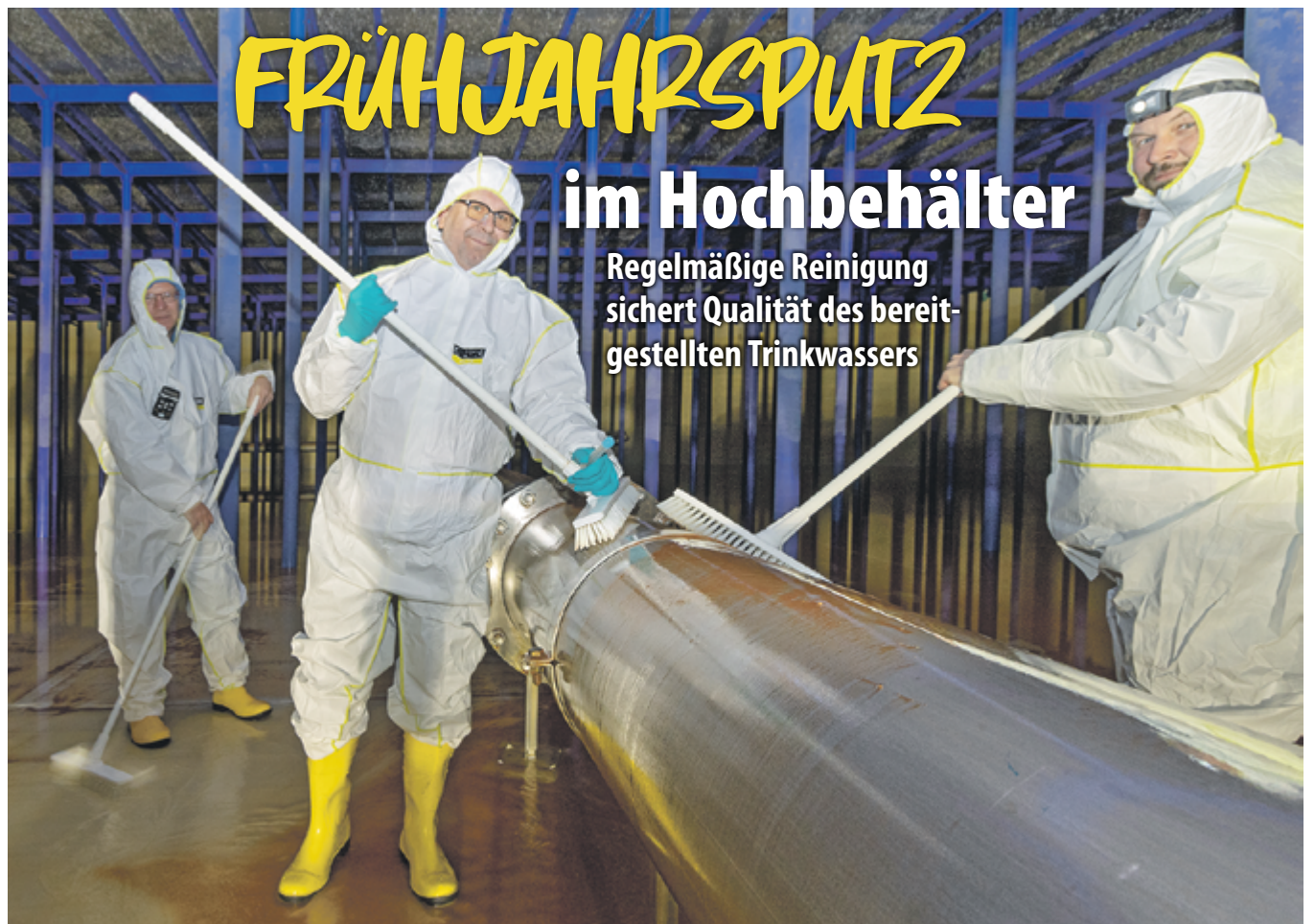
Oliver Klinder, Mirko Heiduk und Daniel Rupp (v. l.) gehörten unter anderem zum „Putzgeschwader“ beim Fototermin im Trinkwasserhochbehälter Zossen. Mit weißen Besen lösten sie die stärkeren Verkrustungen von Wänden und Rohren.
