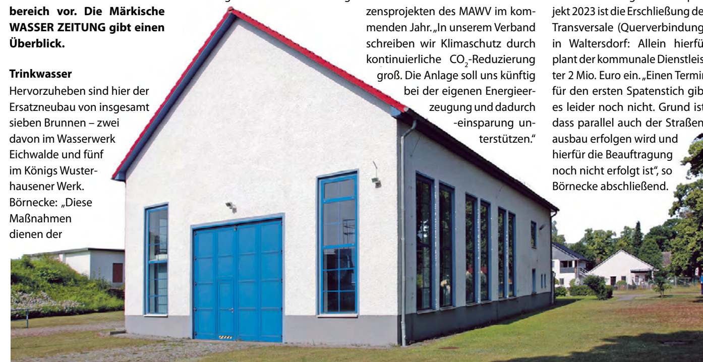
Das Wasserwerk Wildau ist in das große Trinkwasserverbundsystem integriert. Durchschnittlich werden hier 800 m 3 Trinkwasser am Tag gefördert. Für den Fall eines längeren Stromausfalls investiert der MAWV etwa 180.000 Euro in ein Notstromaggregat.
