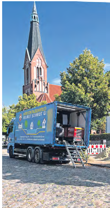
Der MAWV saniert derzeit gut 600 m Trinkwasserleitung in den Gemeinden Eichwalde und Zeuthen. Foto: MAWV
